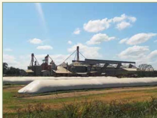
*Centro de acopio de grano. Los silos tipo torre tuvieron que ser complementados con silos tipo bolsa para dar cabida a los niveles de producción.*
